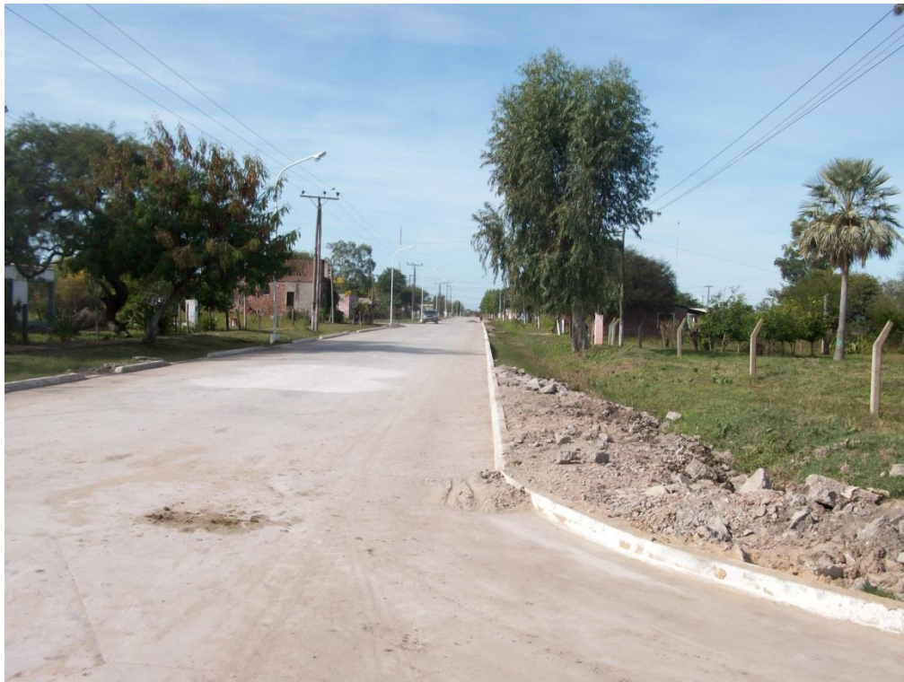
VISTA DE UNA CALLE DE LA LOCALIDAD
