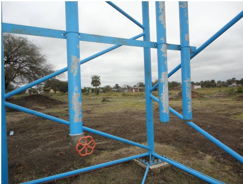
CAÑERIAS DEL TANQUE ELEVADO A ACONDICIONAR
